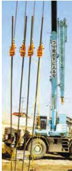
・クランプに噛み込んだ鉄筋4本を確実に移動できます。
