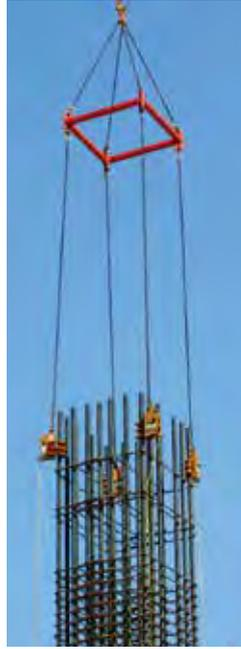
・柱吊用天秤とクランプを使用して
